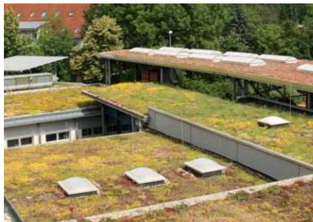
Die Gründächer der JAT bieten Wasserrückhalt, Klimaverbesserung und erweiterten Lebensraum unserer Bienen.
